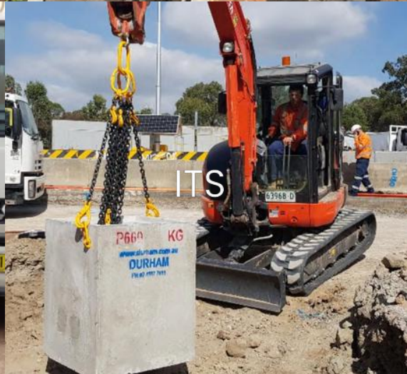
Non Destructive Digging
